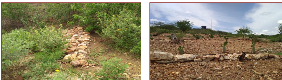
Figura 5 – Utilização de técnicas com barramentos de pedra e recomposição da vegetação para recuperação de áreas degradadas.
