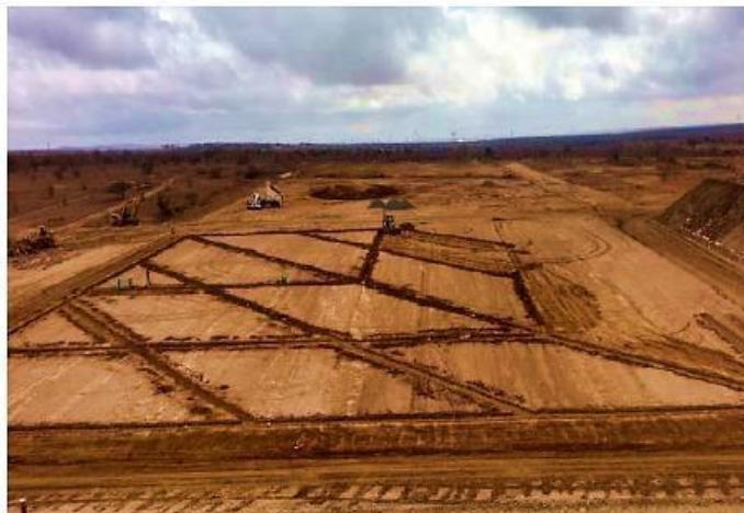
b) Execução da camada de base
