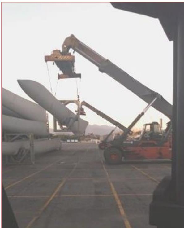
Foto 4 – Reach stackers içando pá eólica
