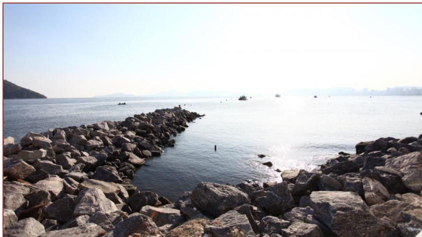
Figura 3. Blocos de enrocamento para proteção dos geobags.
