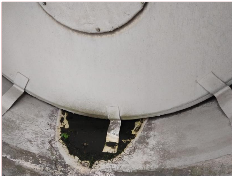
Foto 5 – Água acumulada devido à chuva nas pás eólicas.
