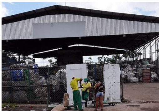
Figura 1: Fachada do galpão da ARAL
