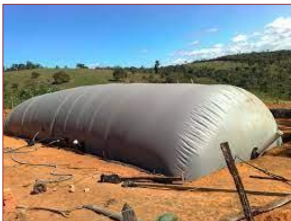
Figura 1 - Biodigestor em operação
